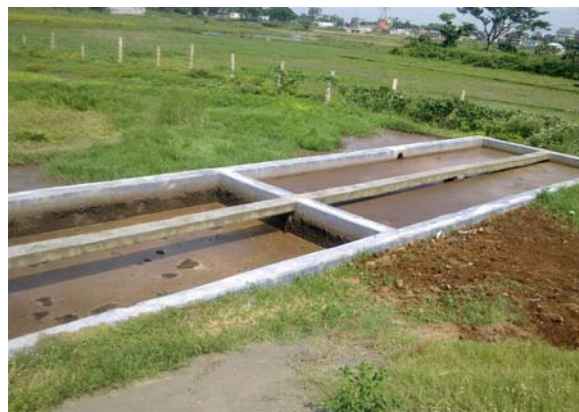
Fig. 3. Slurry bed
